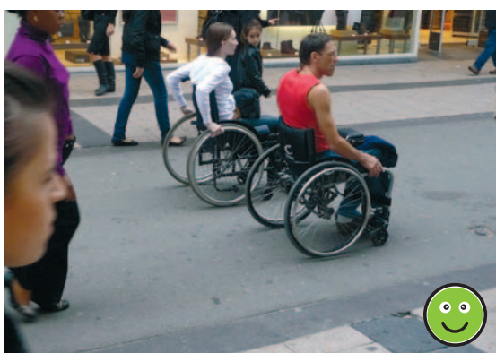
Vlakte overgangen tussen aangrenzende elementen- en asfaltverhardingen in de Brusselse Nieuwstraat
