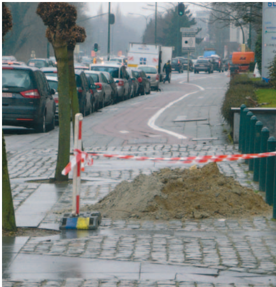
Na ingrepen aan kabels en leidingen moet de verharding in de oorspronkelijke staat worden hersteld
