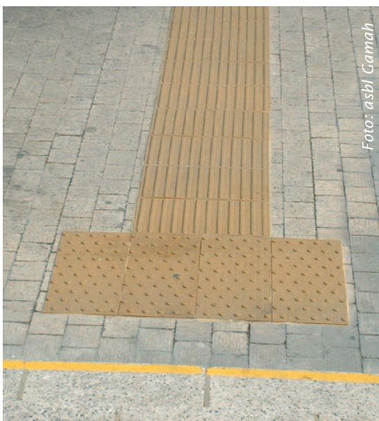
Koud opgelijmde podotactiele tegels
