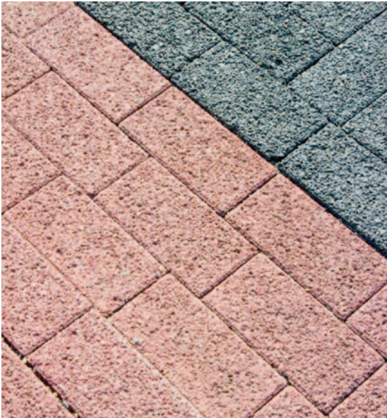
Waterdoorlatende verharding van poreuze betonstraatstenen
