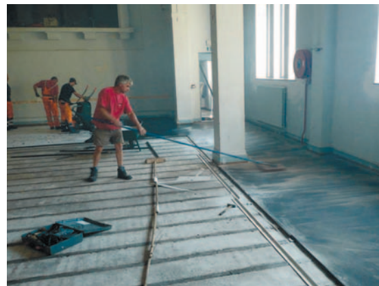
Egaliseren van gietasfalt
