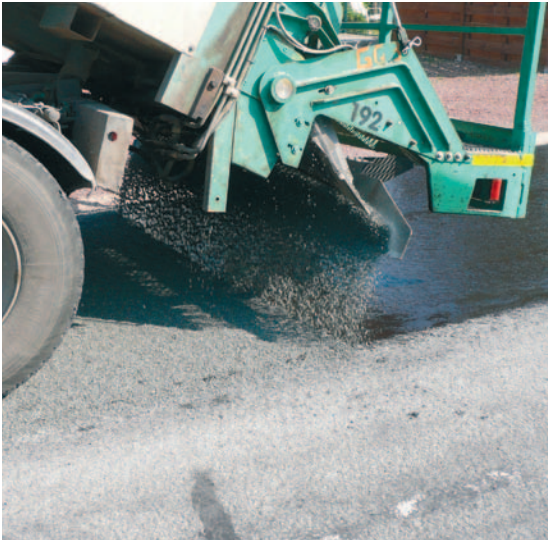
Afstrooien van steenslag op een emulsielaag
