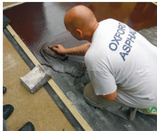
Afstrijken van gietasfalt
