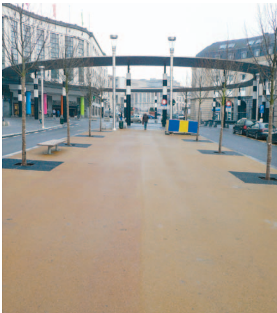
Verharding van gekleurd warm bereid asfalt voor een voetgangerszone in Brussel
