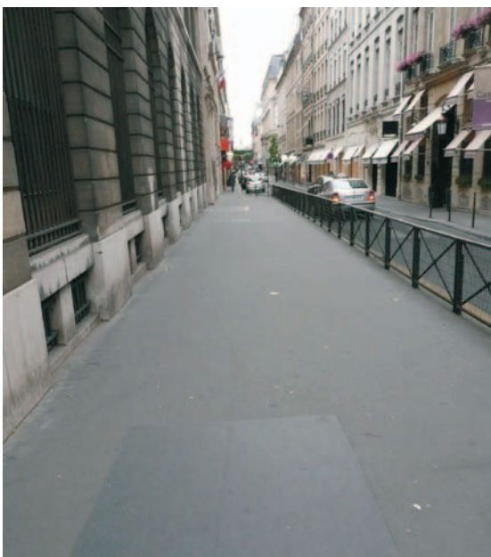
Verharding van gietasfalt voor een trottoir in Parijs
