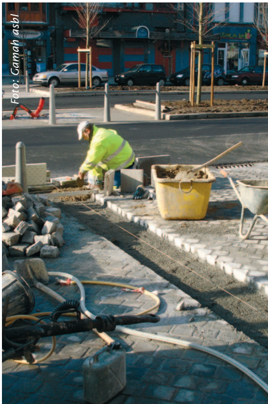
Aanbrenging van podotactiele betontegels
