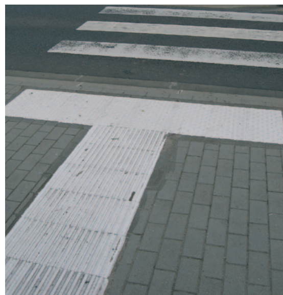
Warm opgekleefde podotactiele tegels
