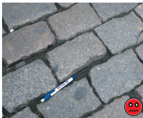
Bestrating met ronde straatkeien en te brede voegen
