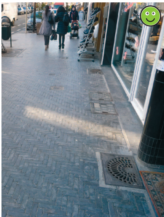
Roosters en deksels horen niet thuis in de looproute
