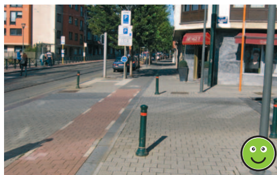
Verhoogde oversteekplaats op hetzelfde niveau en in dezelfde kleur als het trottoir
