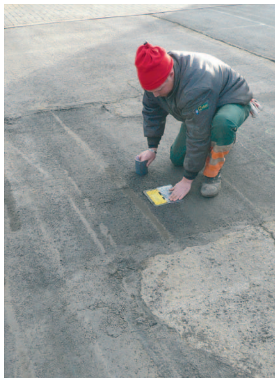
Afdekken van een putdeksel vóór de oppervlakbehandeling
