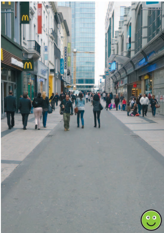
Vlakke goot aan weerszijden van de voetgangervoorziening in de Brusselse Nieuwstraat
