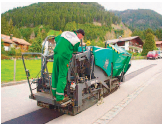
Asfaltspreidmachine met kleine werkbreedte
