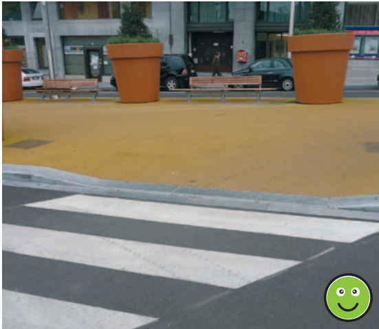
Toegankelijke overgang rijbaan-looproute
