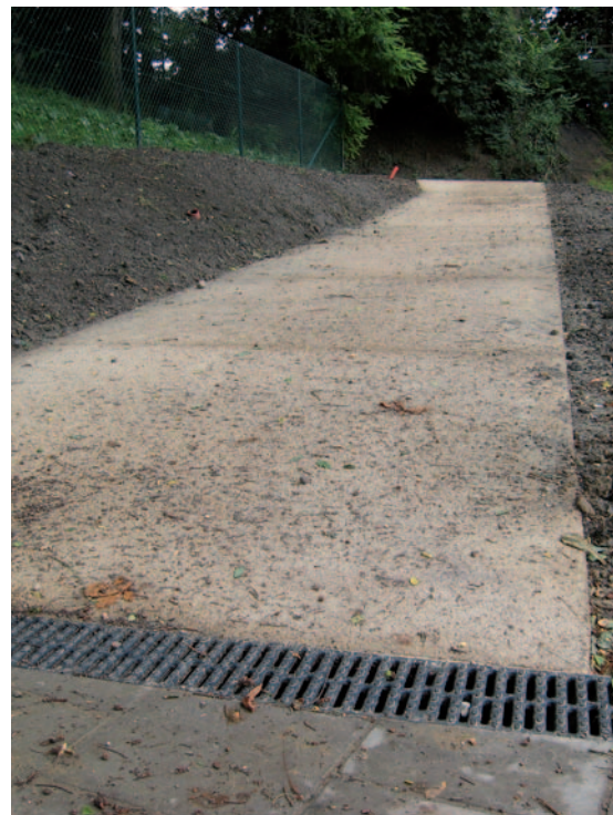
Toerit van uitgewassen beton naar de spoorwegwandering in Woluwe
