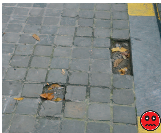
Oneffen loopoppervlak als gevolg van materiaalverlies
