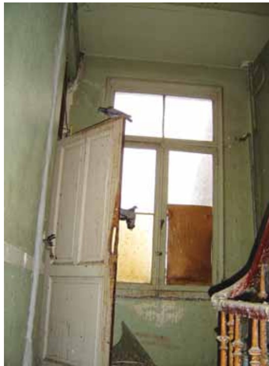
De overloop van de 2e verdieping; de 1e verdieping wordt verhuurd en bewoond
