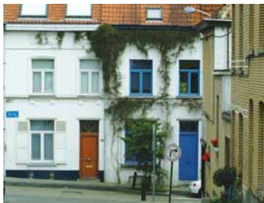
De renovatiepremie dragen concreet bij tot de vernieuwing van de Brusselse privéwoningen.
