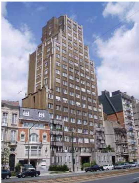
De Amerikaanse wolvenkrabber aan de Generaal Jacqueslaan in Elsene: een flatgebouw uit het interbellum dat in 2006 via de versnelde procedure (art. 227 van het BWRO) werd beschermd
