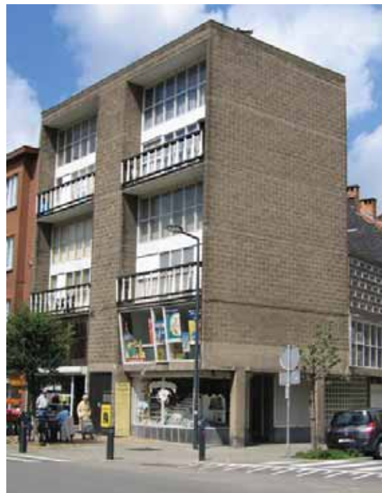
Van Ooteghemgebouw te Evere van architect Willy Van der Meeren
