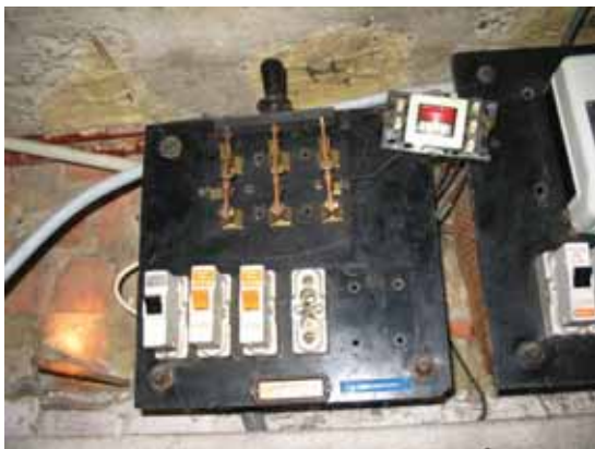
Messchakelaars in plaats van differentiaalschakelaars = levensgevaarlijk!
