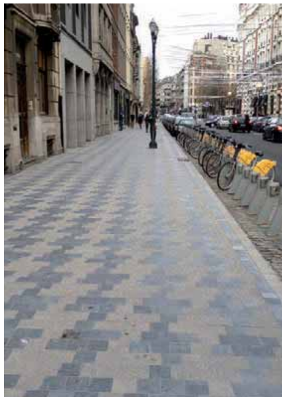
Travaux de réaménagement de la rue Antoine Dansaert, à la suite du permis d'urbanisme délivré le 29/11/2011. Heraanleg van de Antoine Dansaertstraat naar aanleiding van de stedenbouwkundige vergunning, afgegeven op 29/11/2011
