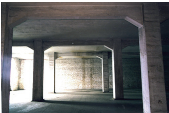
Fig. 7: Zicht op de draagstructuur in gewapend beton van het Openbaar Stapelhuis op de site van Tour & Taxis. Gebouw B. (foto 1998).
