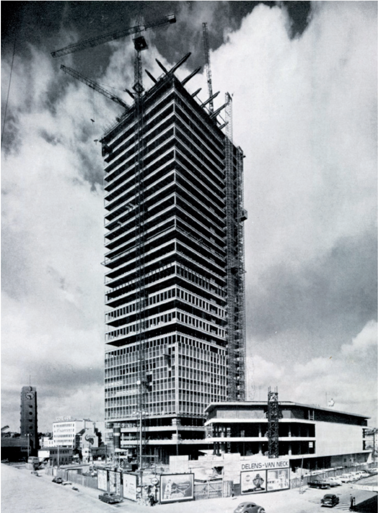
Fig. 4: De bouw van de Zuidtoren met gebruik van PREFLEX-balken [10].
