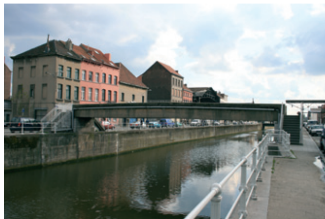
Fig. 6: Voetgangersbrug van de Gosseliesstraat [5].
