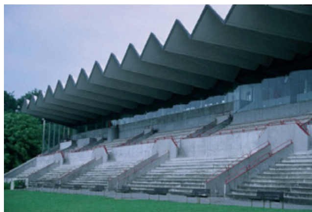
Fig. 6: Gevouwen betonschaal van het hippodroom in Groenendaal (Espion, [7]).
