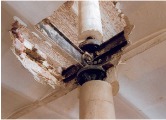
Fig. 3: Opengewerkte vloerconstructie van de lichtgewicht vloer van het Brusselse Pandjeshuis (1859). Alle ijzeren structurele elementen zijn passief beschermd. (foto 1998).
