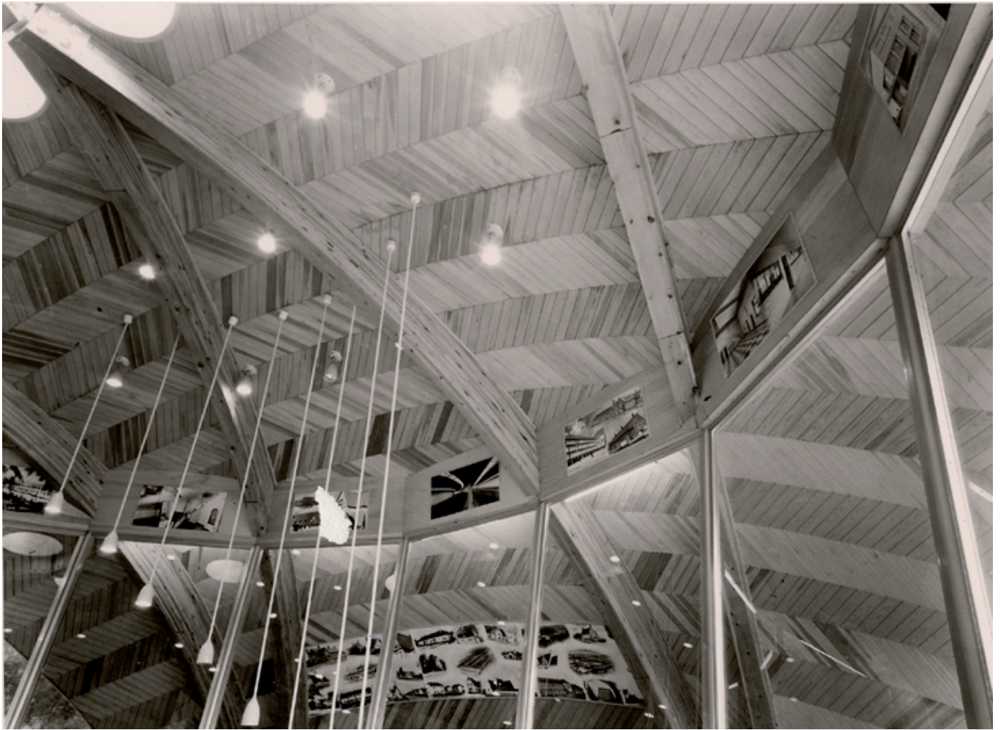
Fig. 2: Het paviljoen van het Kortrijks Dakpannenkantoor, 1957-'58 (Expo 58), Brussel. Arch. G. Bontinck en De Coene (Bron: Stichting De Coene vzw).
