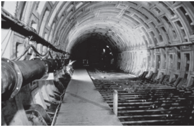
Fig. 7: Metrotunnel onder het Park van Brussel, gerealiseerd met een boorschild (Bron: MIVB).
