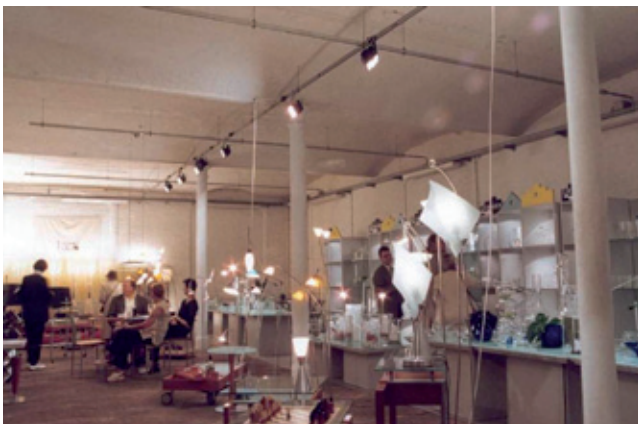
Fig. 2: Pakhuis (1854) herbestedemd als gemeenschapscentrum De Markten. Opgebouwd volgens de typische fireproof mill constructie met gietijzeren balken en kolommen (foto 1998).
