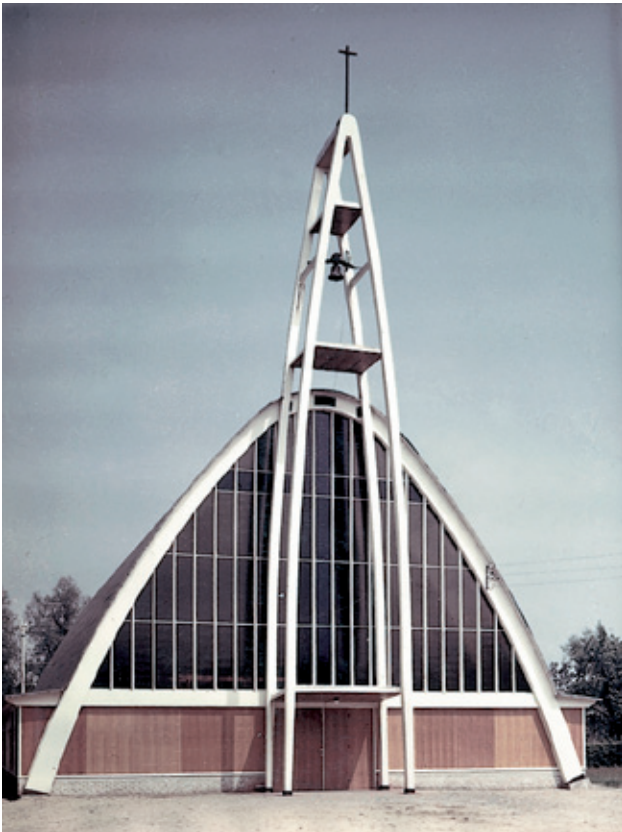
Fig. 1: St. Laurentiuskerk (voorgevel), 1954-'55, Lokeren. Arch. J. Windels en De Coene (Bron: Stichting De Coene vzw).
