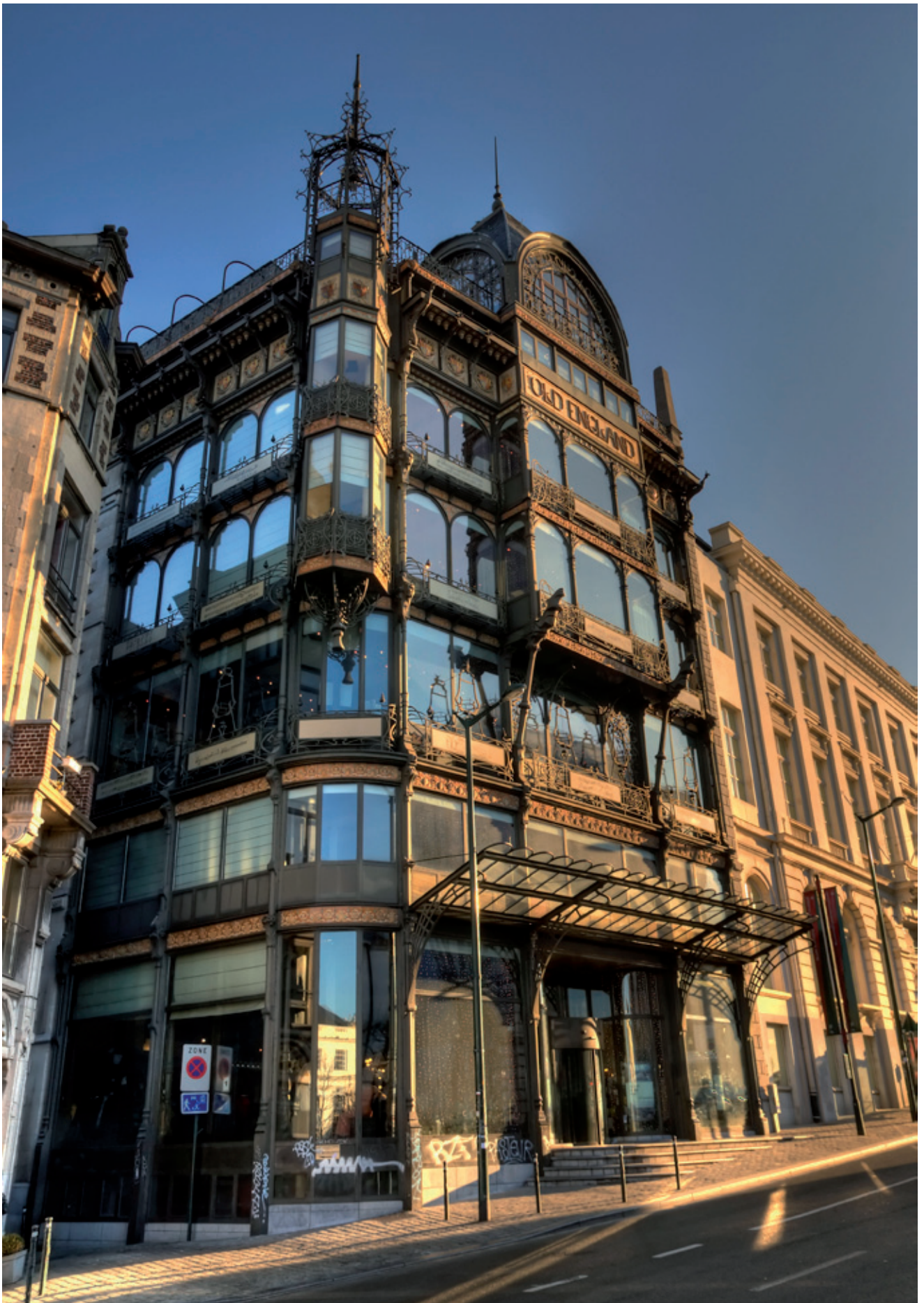
Fig. 6: Bij de herbestemming van het gebouwencomplex aan de Kunstberg werd alle circulatieruimte in Old England (1899) ondergebracht om de metalen draagstructuur onbeschermd te kunnen laten (Foto Baldheretic).
