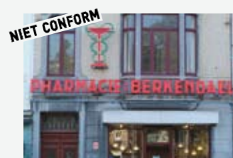
Niet-conform gelijklopend uithangbord, dat zich bevindt op minder dan 0,50 m van de mandelige grenzen.
