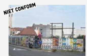
Niet-conforme reclame op de omheining van een niet-bebouwd terrein, die bijna de hele omheining bedekt.
