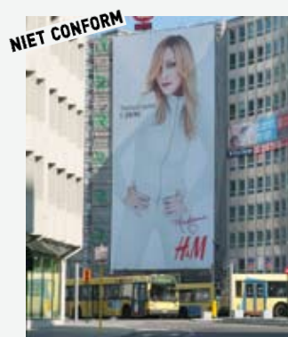
Niet-conforme reclame op een werfdekzeil, omdat de bovenste rand ervan zich meer dan 12 m boven de grond bevindt.
