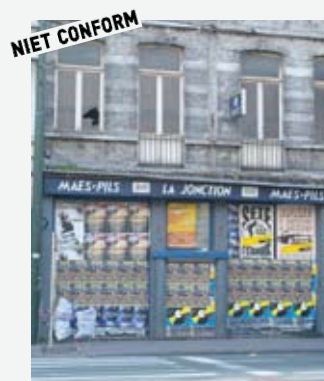
Niet-conforme reclame want reclame is verboden op leegstaande of ongebruikte gebouwen.
