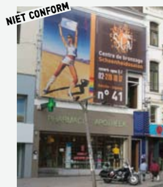
Niet-conforme reclame-inrichting, die de woonbaarheid in het gedrang brengt door overlapping van gevelopeningen.
