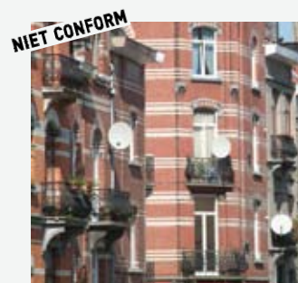
Niet-conforme toestand: schotelantennes aan de straatgevel.
