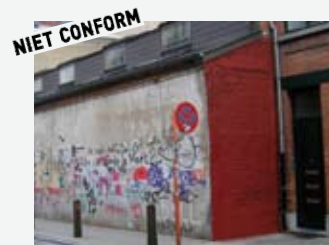
Niet-conforme benedenverdieping, want ze bevat minder dan 20% gevelopeningen of andere openingen.
