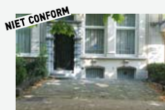
Niet-conforme toestand: achteruitbouwstrook ingericht als parkeerruimte en bedekt met ondoorlaatbare materialen.
