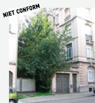
Zijdelingse inspringstrook: niet-conforme toestand.
