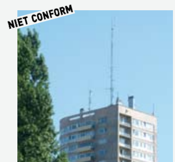
Fig. 10B: de antenne voor mobiele telefonie is niet conform omdat ze meer dan 4 meter uitsteekt boven het dak van het gebouw.
