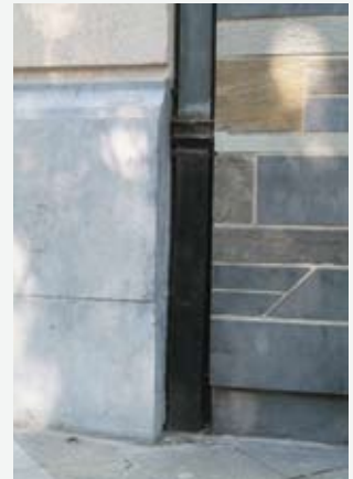
Regenpijp geïntegreerd in de gevel.
