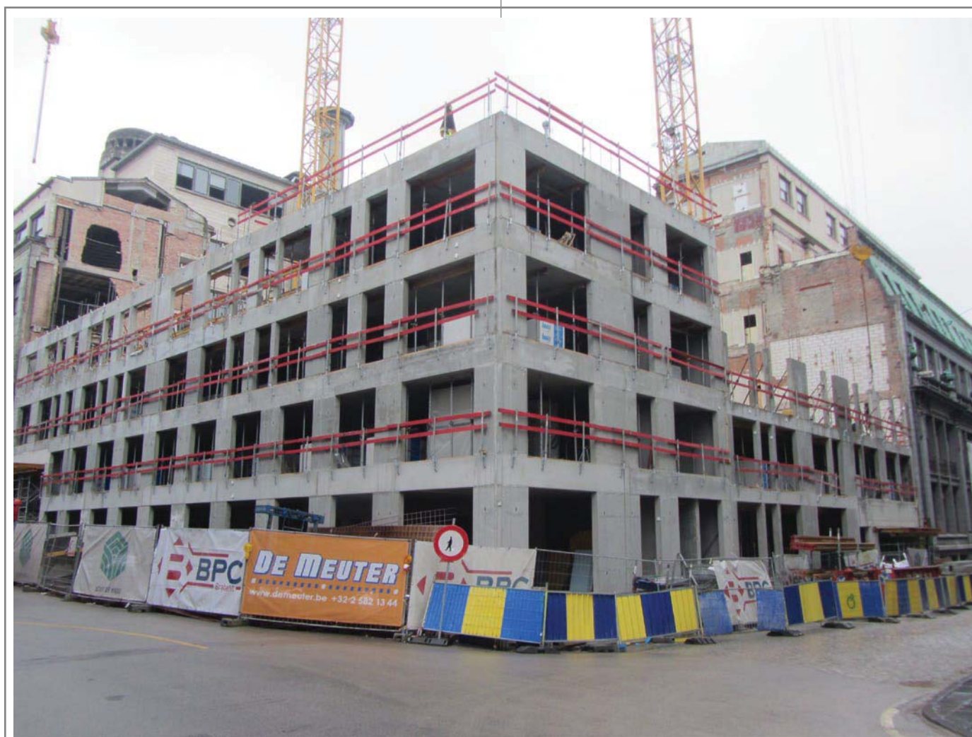
Projet « Chambon » de construction de plus de 200 appartements suite à démolition de bureaux dans le quartier des Martyrs à Bruxelles-Ville (Pentagone) - photo janvier 2014
