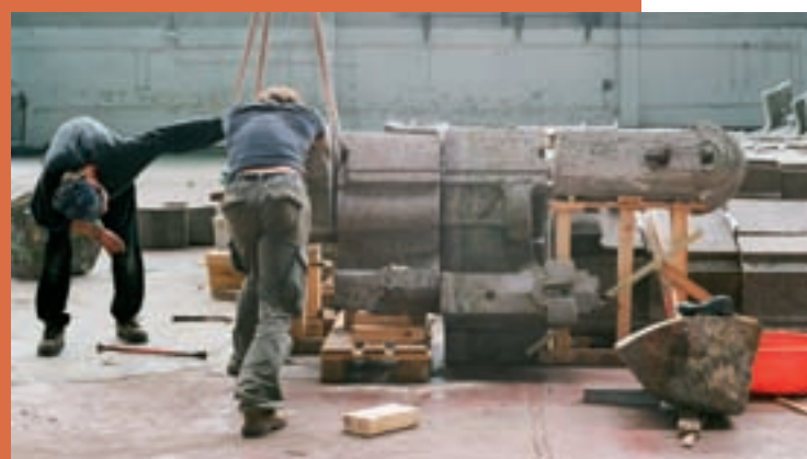
Heropbouw van de gevel van het Hotel Aubecq
