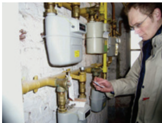
Controle van de gasmeters tijdens een controlebezoek
