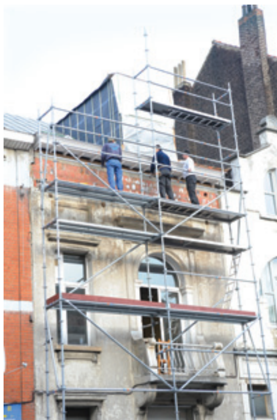
De premies voor gevelverfraaiing dragen bij tot de verbetering van het aanzicht van de gebouwen langs de Brusselse straten.
