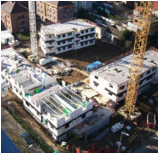
Constructie van 65 woningen in de Jules Lahayestraat (Jette), in het kader van het gewestelijk huisvestingsplan
