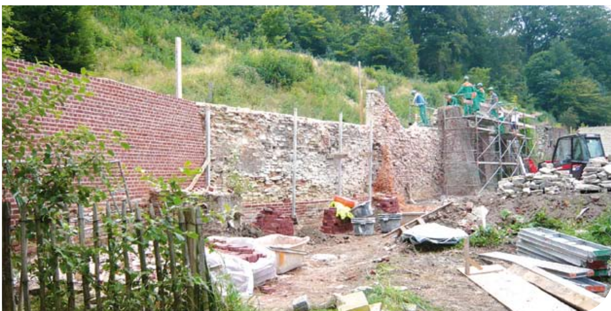
Restauratie van een omwallingsmuur van de priorij Rood Klooster
