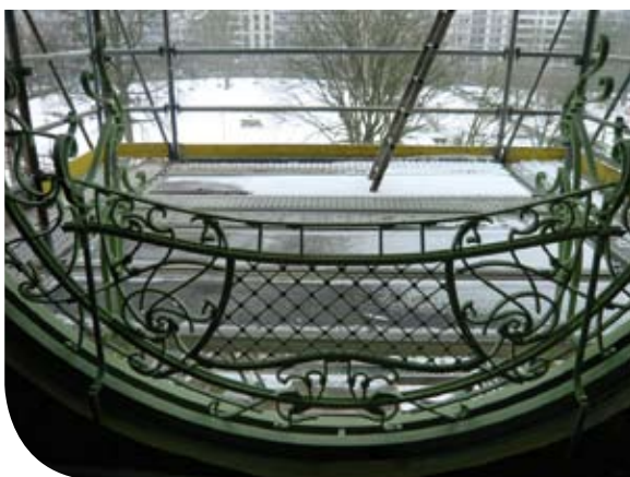
Heropbouw van de gevel van het huis Saint-Cyr in Brussel
