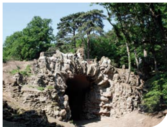
Restauratie van de rotsstenen brug in het Terkamerenbos, in het kader van de Belirisakkoorden
