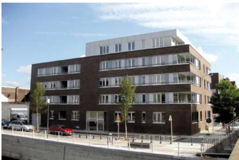
WC Heyvaert - Hoek Gosseliesstraat & Nijverheidskaai, Molenbeek - Baumans-Deffet sprl
