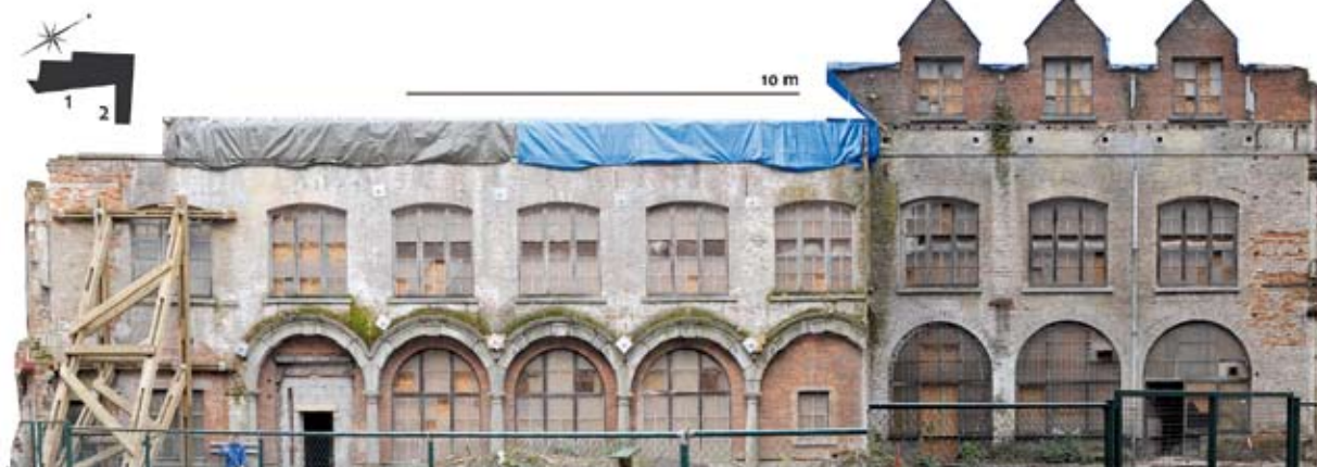
Vleugel I - oostgevel
