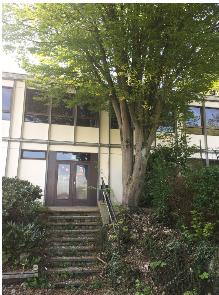
Vue 8 : entrée salle de ports.
