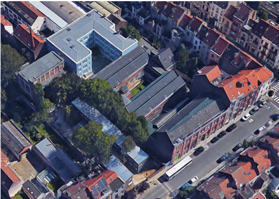
Vue 3D du site existant © GoogleMaps
