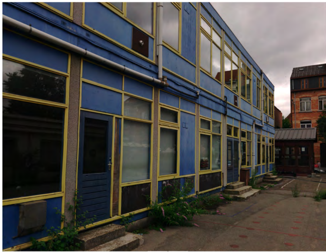
PHOTO 12 – INTERIEUR DU SITE
