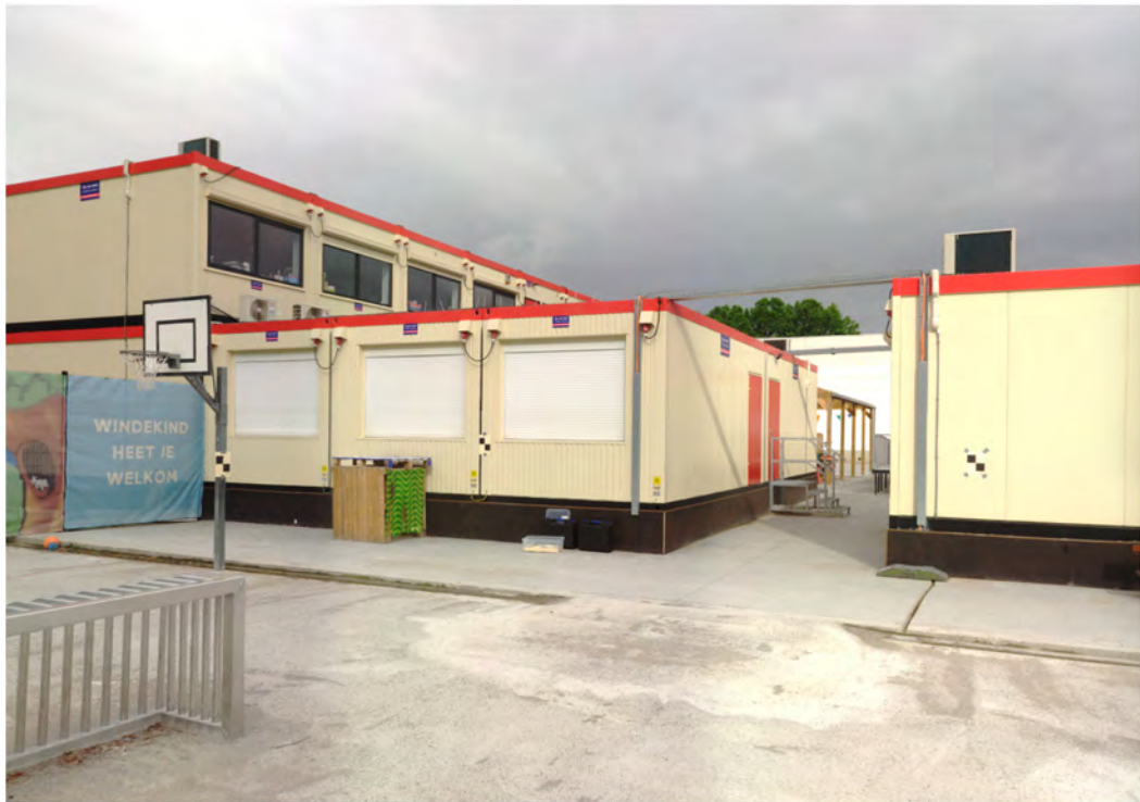
PHOTO 14 – INTERIEUR DU SITE
