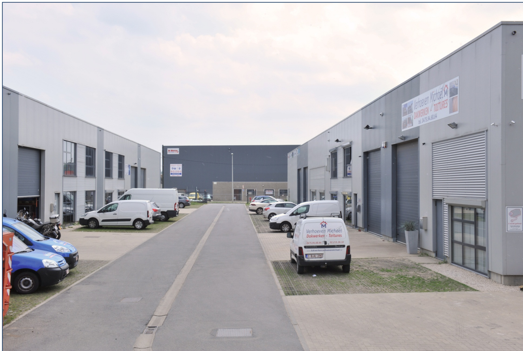
Parc PME privé
