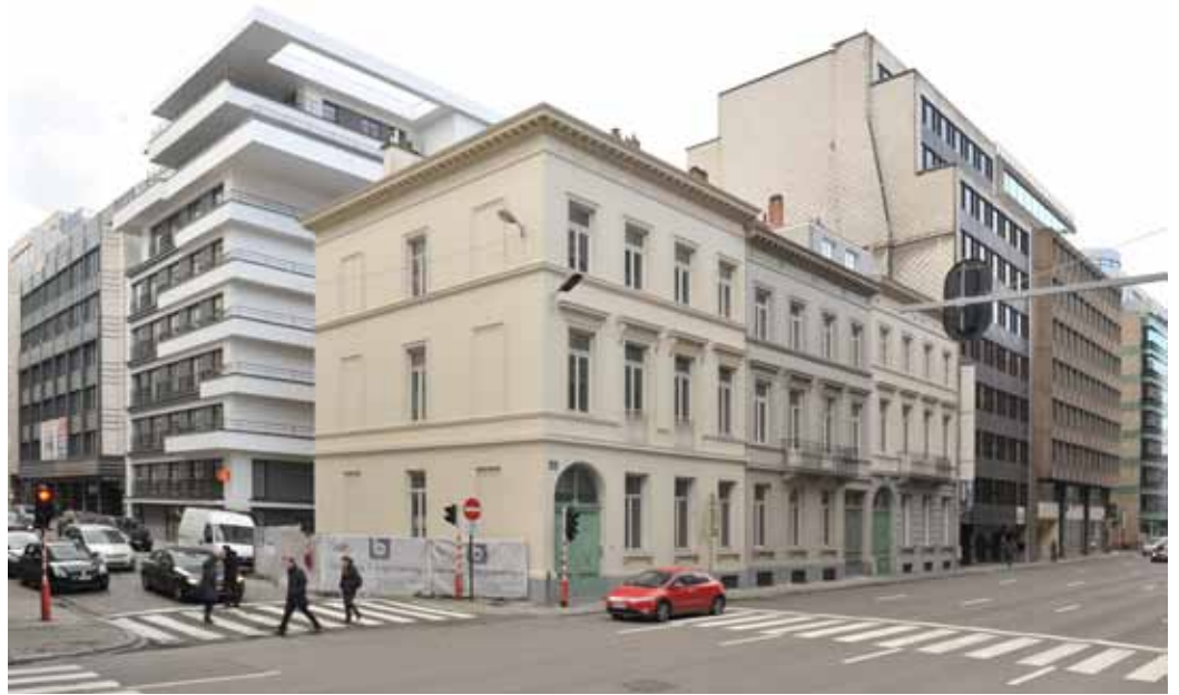
Conversion en appart- hôtel, rue Belliard Reconversie in een apparthotel, Belliardstraat Conversion into an apart-hotel, rue Belliard
