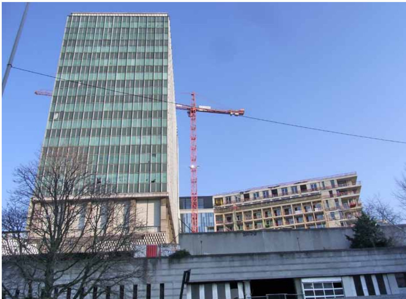
L'ex-Cité administrative en attente d'une restructuration. / Het voormalige Rijksadministratief Centrum wacht op een herstructurering. / The former Cité administrative de l'État awaiting restructuring.
