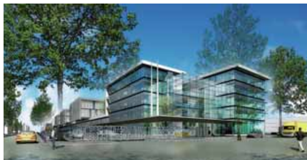
BILC SUIVANT DEMANDE DE PERMIS D'URBANISME EN COURS DE TRAITEMENT ARCHITECTES : ACCARAIN ET BOULLIOT
