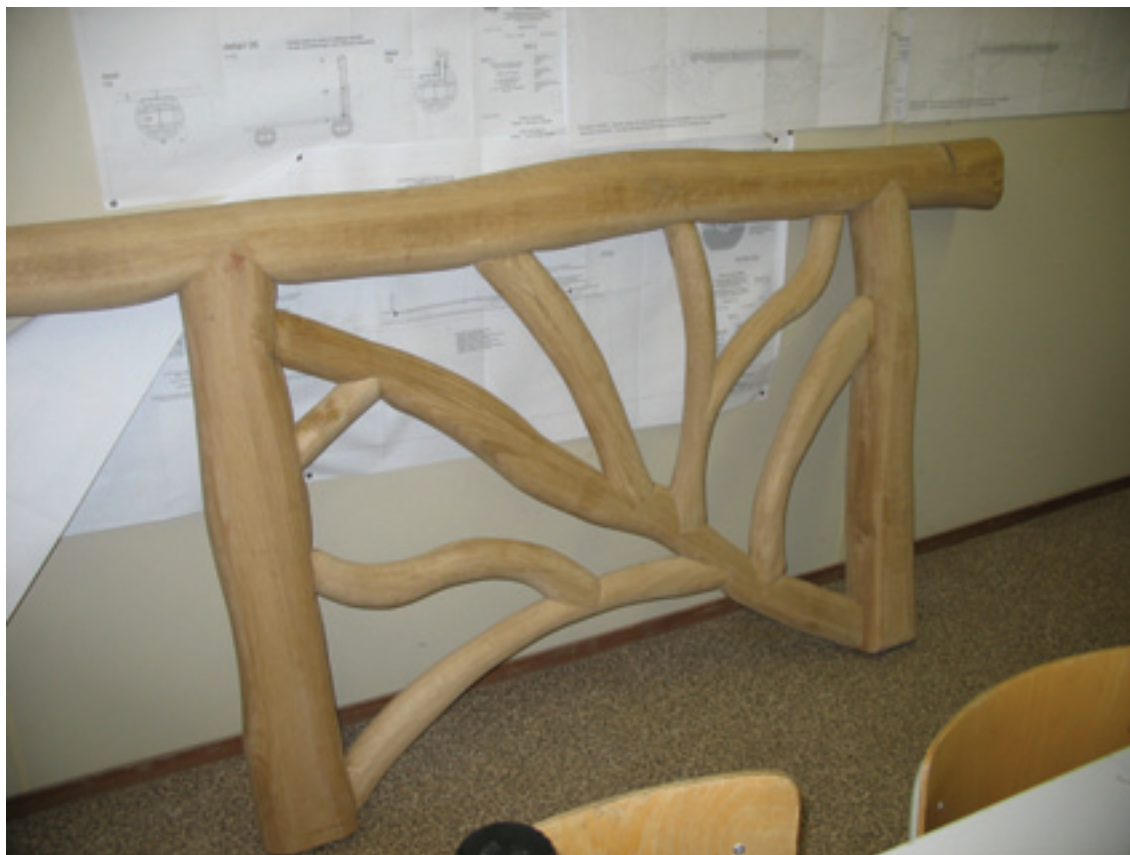
Balustrade du pont du Bois de la Cambre refaite à l'identique.
