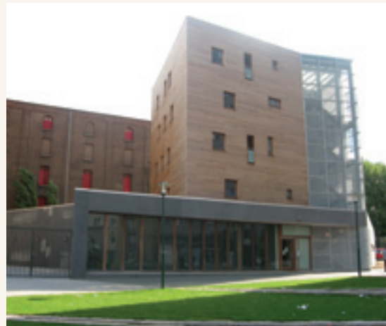
Maison d'accueil d'enfants et logements, angle rue F. Brunfaut et rue E. Pierron, Molenbeek-Saint-Jean. Arch.: Eric Willemart et Hubert Burtonboy.
