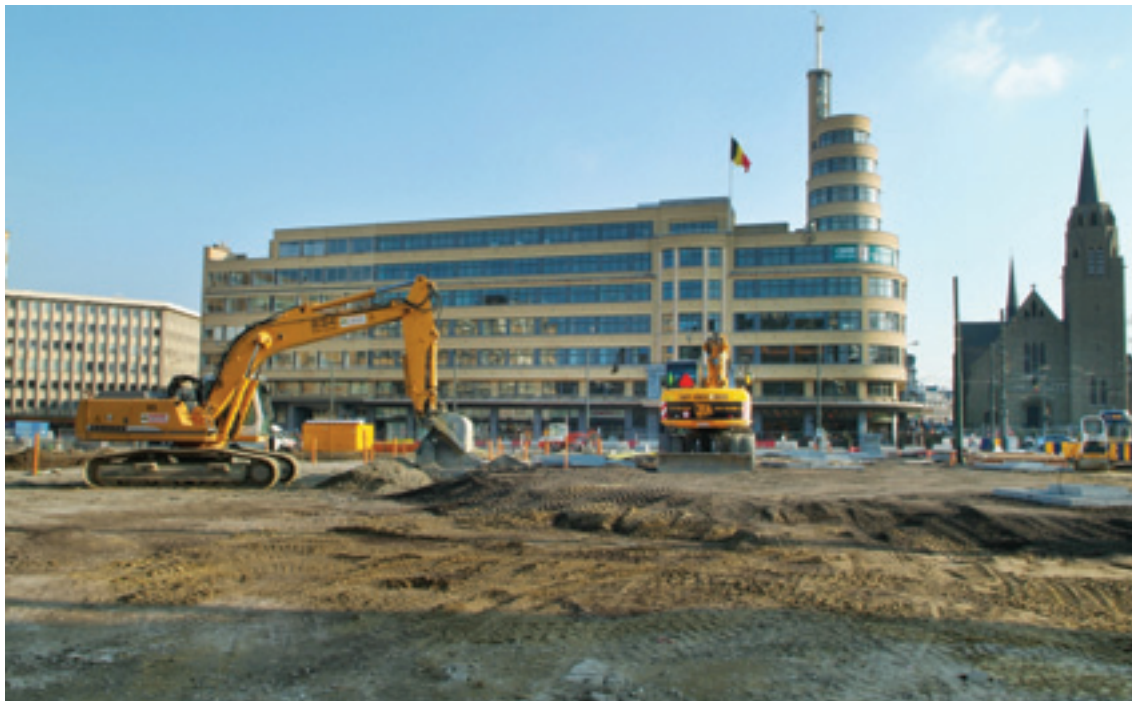
La place Flagey avant son réaménagement.
