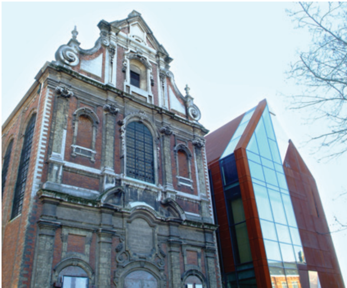
Restauration de l'église ancienne des Brigidines (Bruxelles-Ville).
