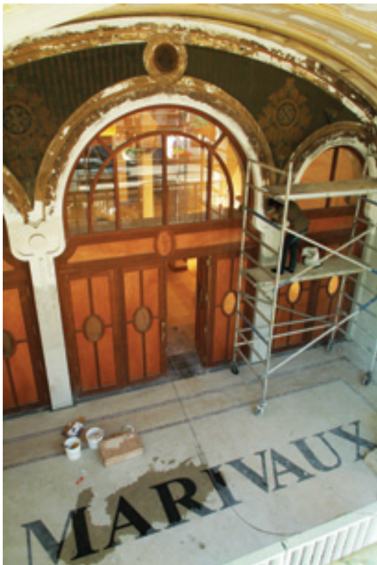
Restauration de l'ancien cinéma Marivaux (Bruxelles-Ville).
