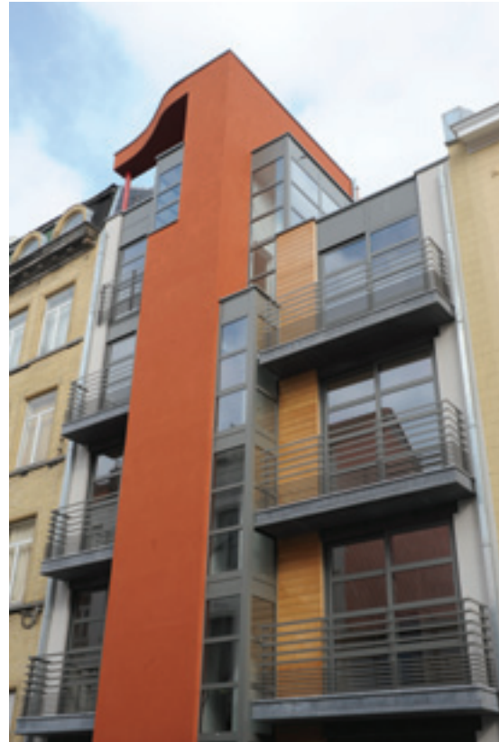
Rue des Mégissiers, 3-5, Anderlecht. Arch.: Pierre Accarain - Marc Bouillot architectes associés SA.
