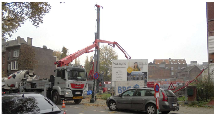
Figure 33 : Etat d'avancement du chantier en face du site (ARIES, 2017)
