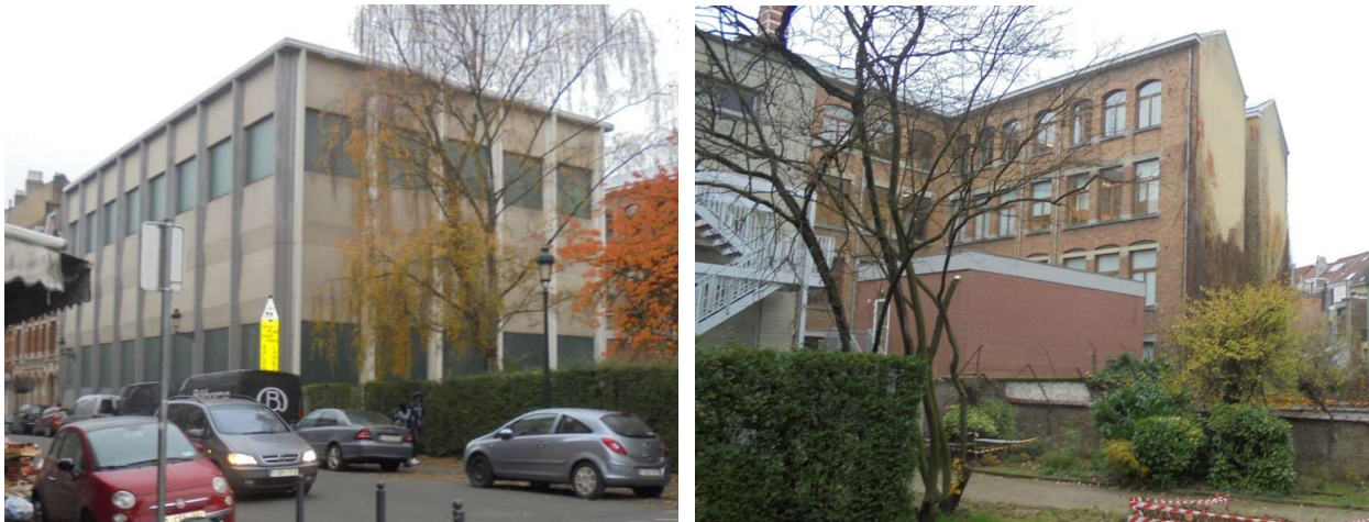
Figure 27 : Vue des bâtiments singuliers au sein du tissu aux alentours du site (ARIES, 2017)
