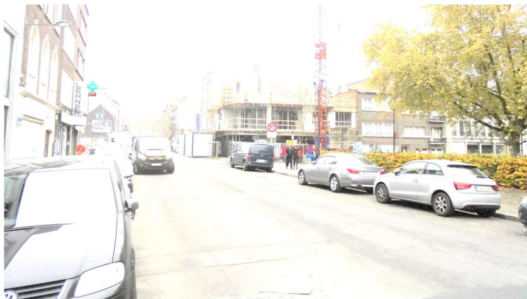
Figure 78 : Vue sur la chaussée de Helmet à hauteur du carrefour avec l'avenue Voltaire (ARIES, 2017)
