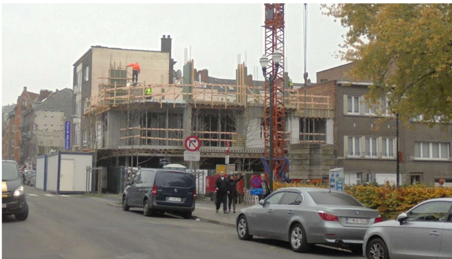
Figure 35 : Etat d'avancement du chantier (ARIES, 2017)
