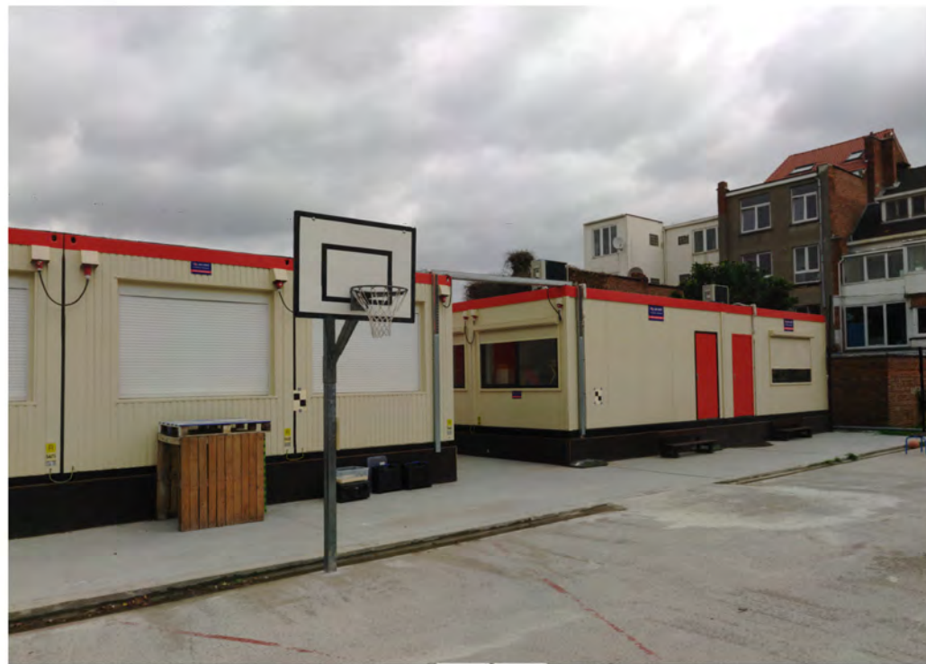
PHOTO 15 – INTERIEUR DU SITE
