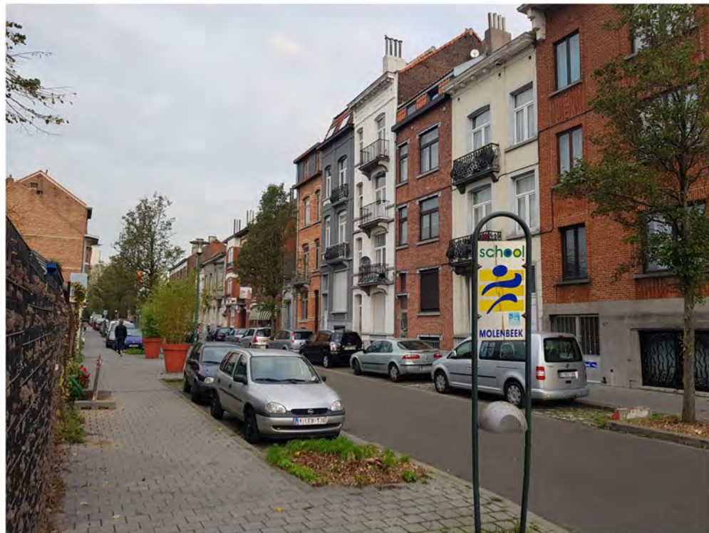
PHOTO 6 – RUE JEAN-BAPTISTE DECOCK VUE NORD – EST
