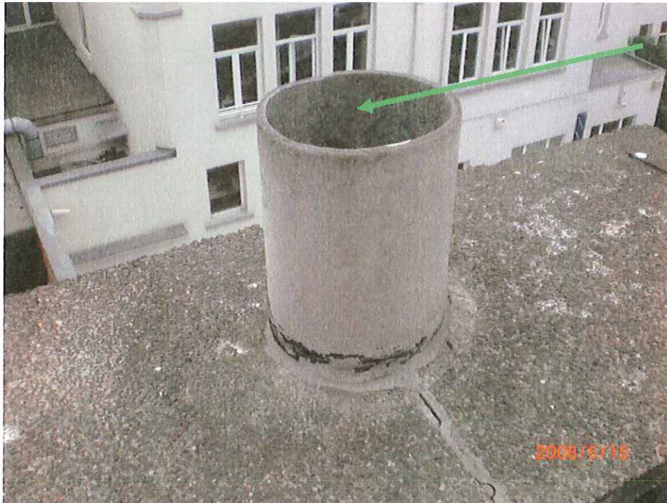
Photo n° 04 : Bâtiment B – Niveau 0 – Hall – Pare-étincelle – POSITIF
