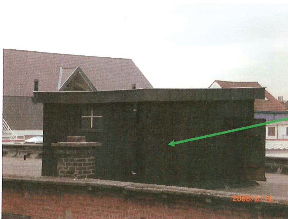
Photo n° 14 : Bâtiment A – Toiture – Cabanon machinerie ascenseur – Bardage – NEGATIF
