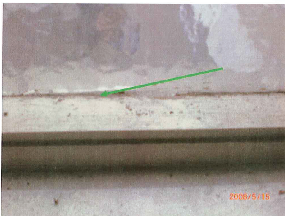
Photo n° 10 : Bâtiment A – Niveau +2 – Toilettes – Joints de fenêtre – NEGATIF
