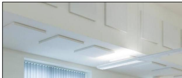
**Figure 4 : Exemple de panneau absorbant collé (Source : Rockfon)**
