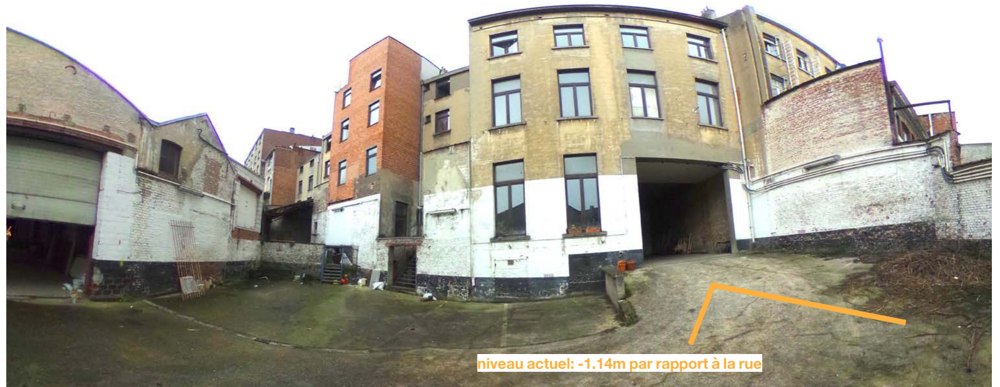
Situation actuelle: partie gauche du site 1,14 m plus bas que le niveau de la rue
